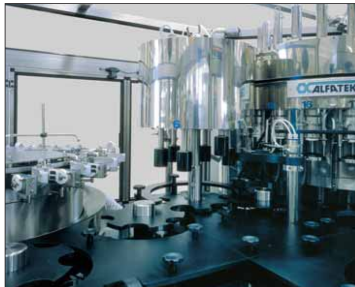
Torretta Deox con tunnel di protezione a gas inerte tra la Deox e la riempitrice
